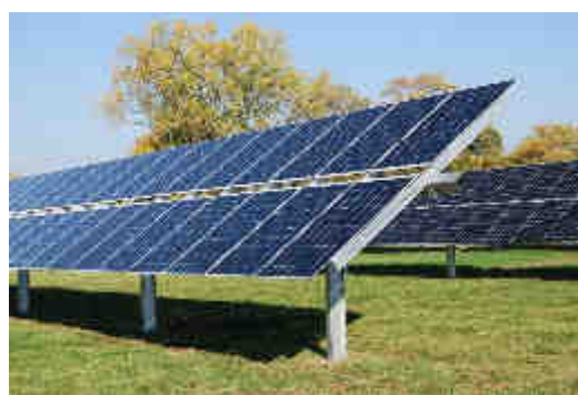
Figur 2: Solceller monteret på stativer med trackermekanisme
