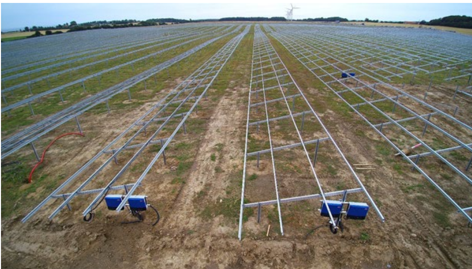
Aluminiumsstativer påsat invertere (blå)
