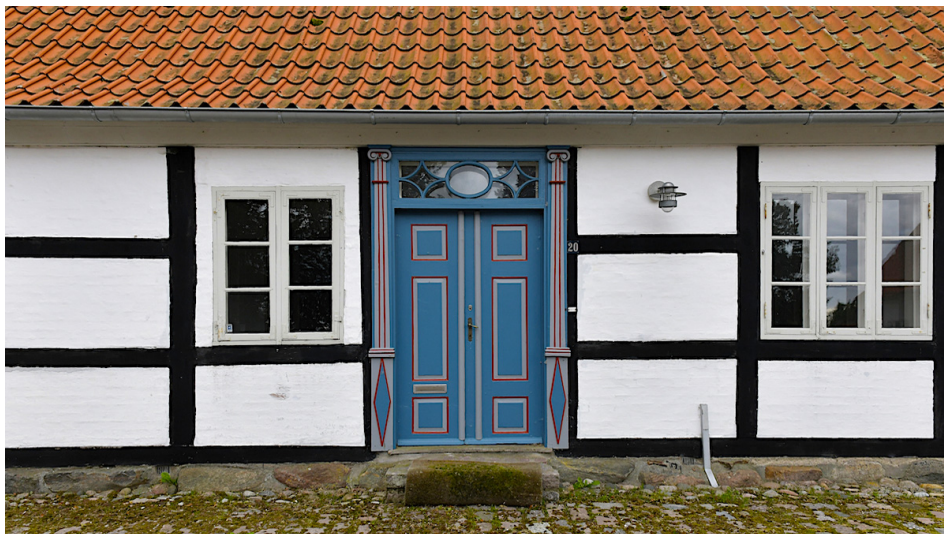
KOLIND PRÆSTEGÅRD | INDGANGSDØR OG FACADE
