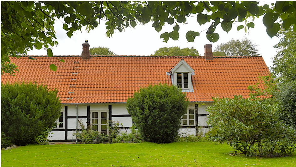
KOLIND PRÆSTEGÅRD | FACADE MOD HAVEN
