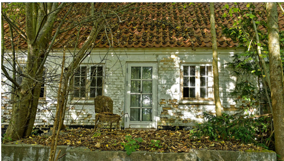
VIBROGAARD OKTOBER 2020 | STUEHUS TERRASSE MOD SYD
