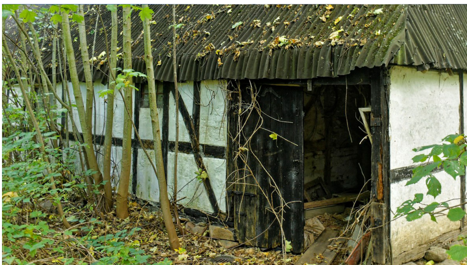
VIBROGAARD OKTOBER 2020 | LADEBYGNING MOD ØST
